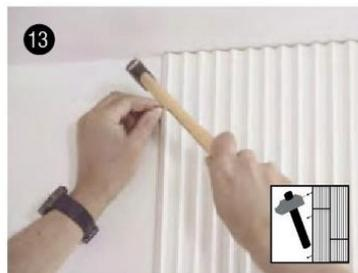
Большая площадь отделки: используйте финишные гвозди без шляпки с боковой стороны панели для дополнительной фиксации
