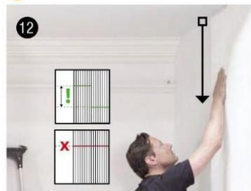
Начните монтаж второго ряда (шаги 1-10), устанавливая панели от потолка вниз
